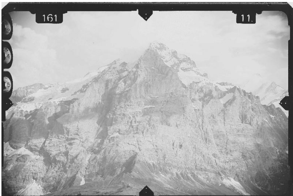
Abb. 32: Terrestrische Aufnahme vom 26. August 1926 ab der Station Genschberg mit dem Phototheodolit Wild Nr. 11 (swisstopo, Bildsammlung, Glasplattennegativ 10x15 cm, Inv. Nr. 000-171-974; https://s.geo.admin.ch/8a554723d2 ).
