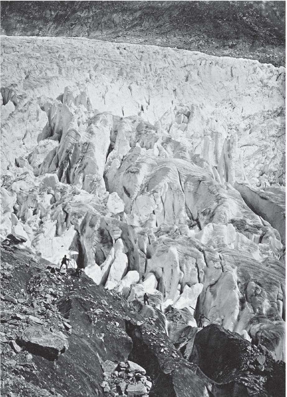
ABB.6 Der Kampf mit dem Gletscher: Ingenieur am Messtisch mit Gehilfe und Lattenträger bei der Kartierung des Spaltengewirrs an der
